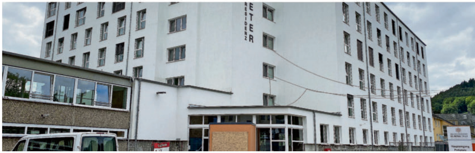
Der Keller und das Erdgeschoss der Seniorenresidenz St. Peter Ehrang waren überflutet. Bis zu zwei Meter stand das Wasser hoch. Nun wird saniert.
